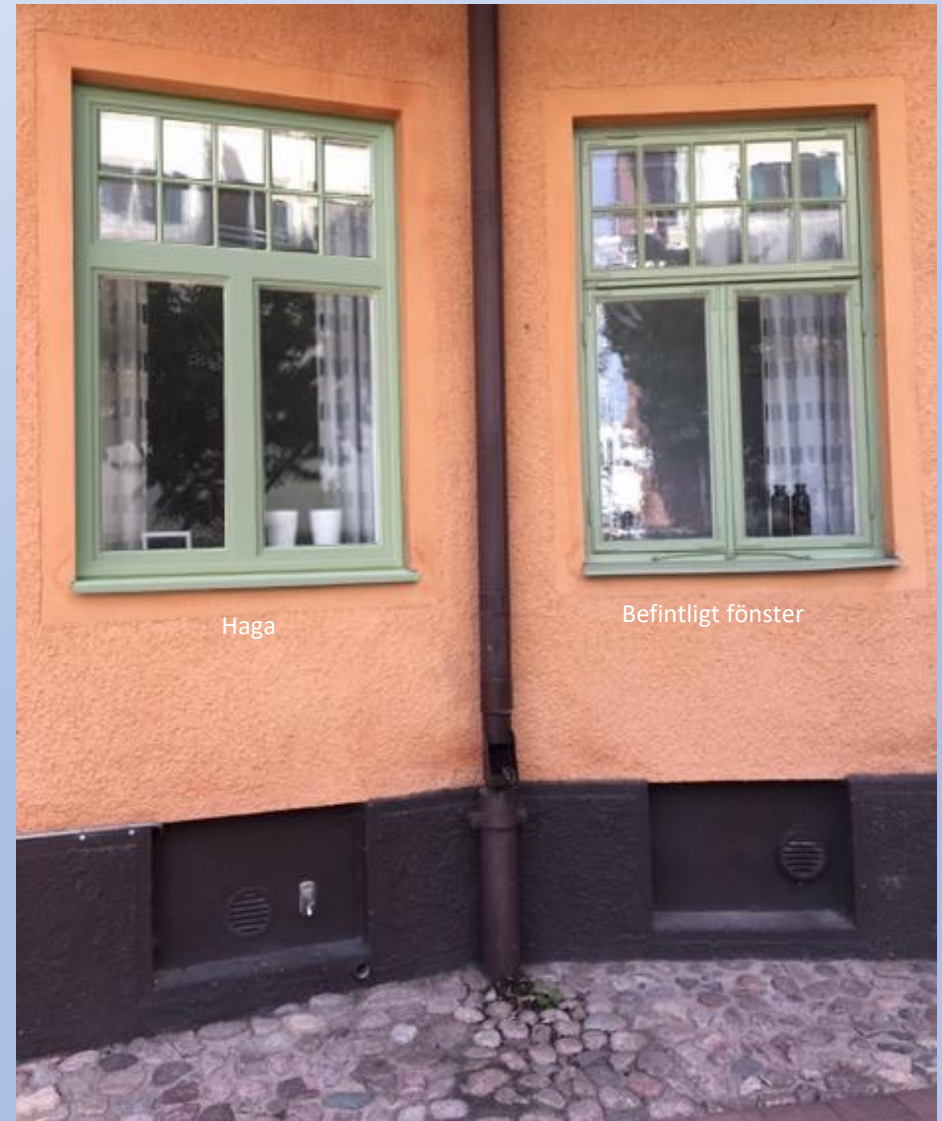
Haga i 3D som treluftare i befintlig fasad
